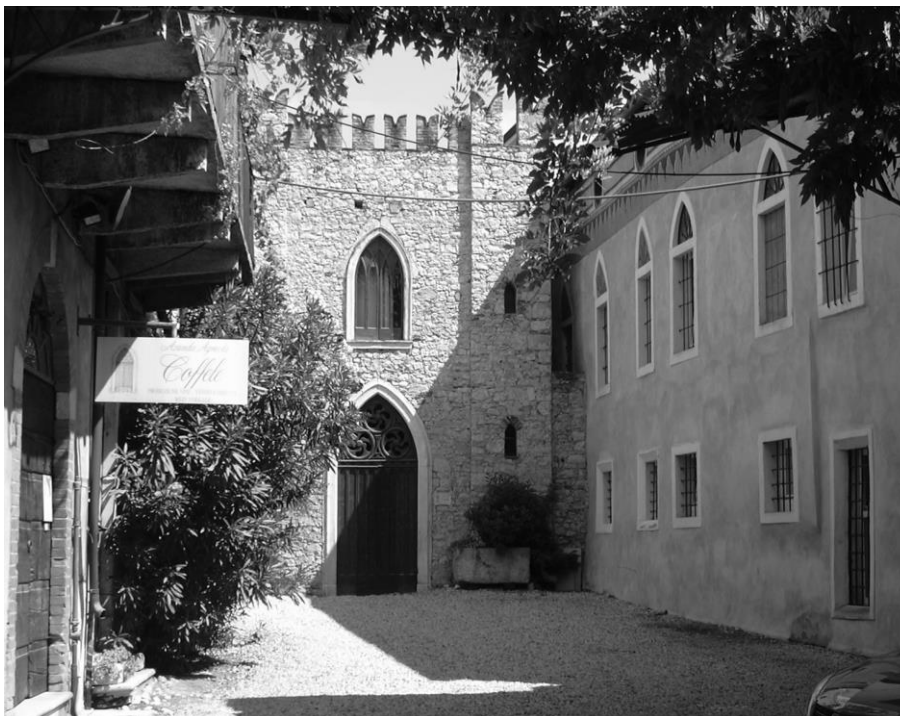
Fig. 1 - Cantina Coffele ubicata nel centro storico di Soave.
